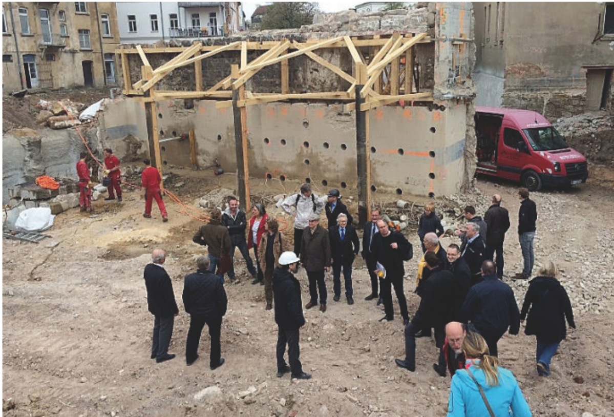
Mit Betonkorsett gesichert: Die ältere der beiden Stadtmauern erhebt sich mehrere Meter hoch.
