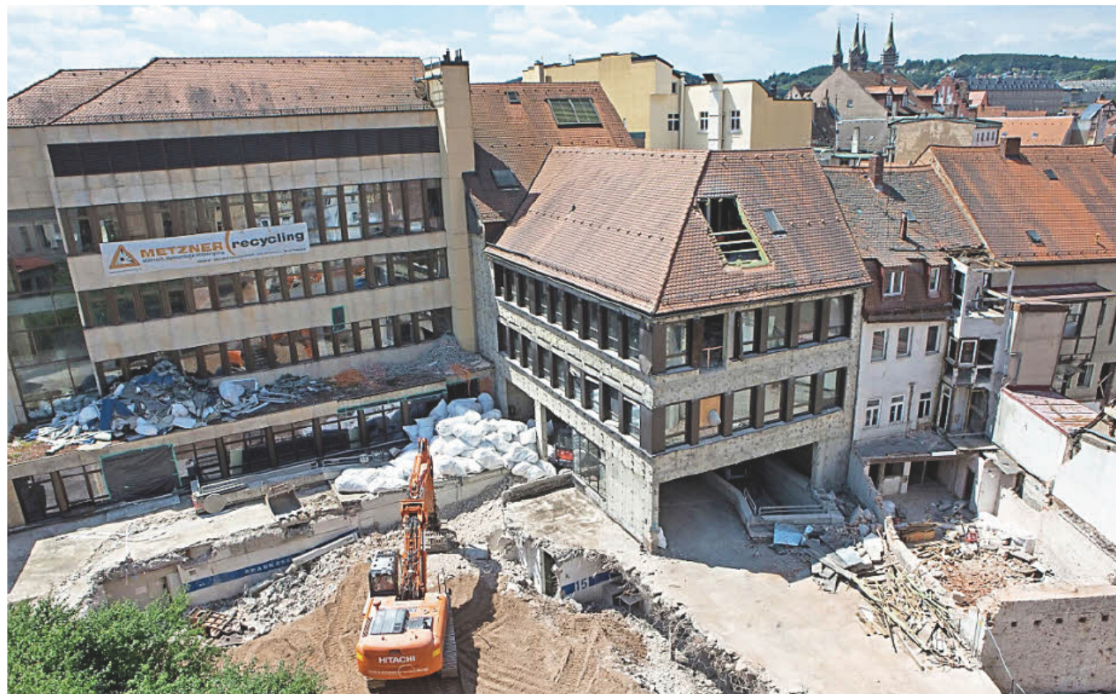
Das Gelände zwischen Langer Straße und Franz-Ludwig-Straße ist schon weitgehend freigeräumt
